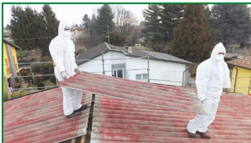
Bonifica lastre di copertura in cemento amianto
