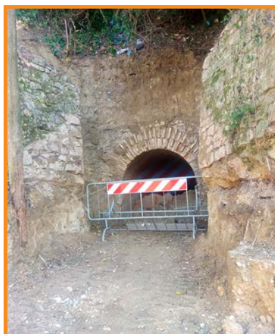
Ingresso al rifugio
